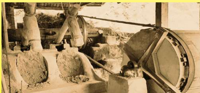
Macchine di produzione tradizionale (水碓 shui duì) per la produzione di polveri utilizzate per la fabbricazione di porcellana elettrica (collezione privata)
